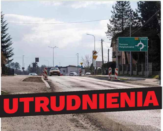
■ Na skrzyżowaniu ulic Libowiec, Cieszyńskiej i Kilińskiego zaplanowano ostatni etap robót. FOT. UM JASTRZĘBIE
