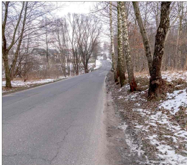
■ Ul. Dąbrowskiego ma przejść gruntowną przebudowę. Miasto przygotowuje przetarg. FOT. UM JASTRZĘBIE-ZDRÓJ
