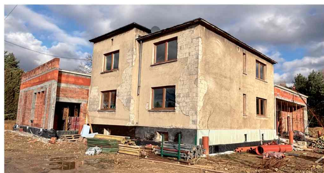
■ Nowa siedziba w budowie
