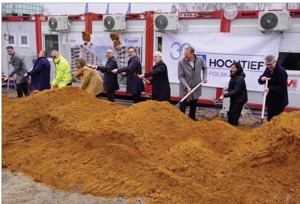
■ Rozpoczęła się budowa nowego osiedla w Żorach. Partner prywatny odpowiada za finansowanie i utrzymanie budynków przez 20 lat. FOT. UM ŻORY
